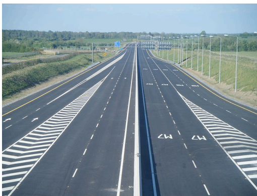
Entrée et sortie sur la M7
