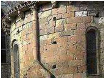
Un modillon est un petit support de forme quelconque, placé sous une corniche, qui n'est souvent qu'un élément de décoration, autrement dit une pierre avançant dans le vide, perpendiculairement au mur.
